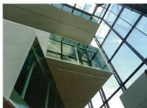
Binnen een L-vormig hoekgebouw is een 19 meter hoog atrium geplaatst met daarin gestapelde kantoorunits.
