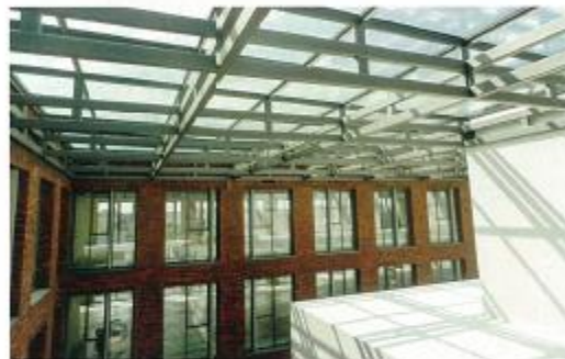
De samengestelde profielen fungeren als vierendeelgiggen.
